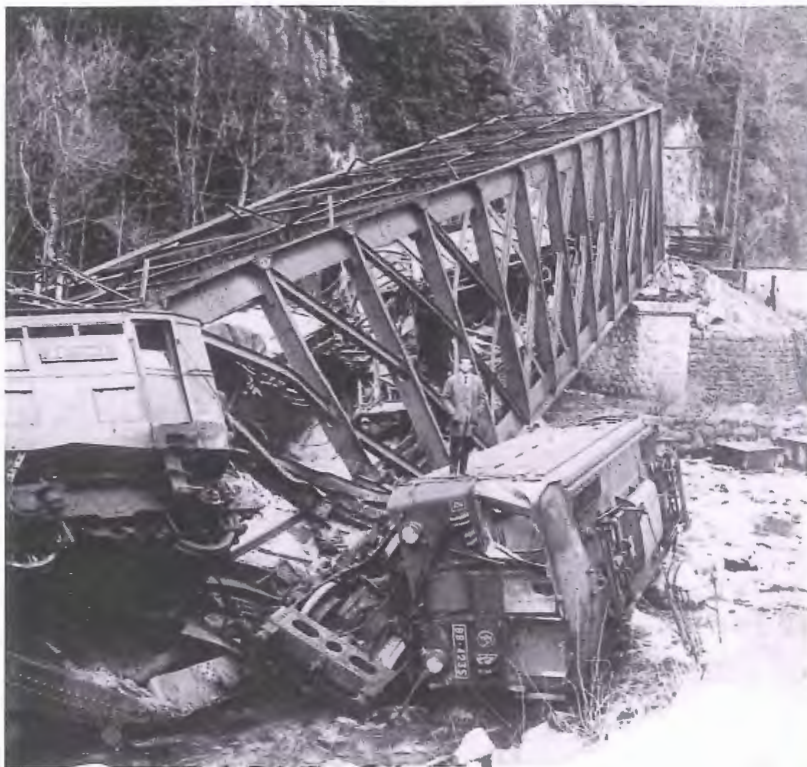
Le pont de l'Estanguet après l'accident du 27 mars 1970. Les structures métalliques ont été arrachées et l'ouvrage a plongé dans le gave d'Aspe.
