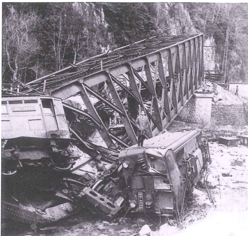
Le pont de l'Estanguet après l'accident du 27 mars 1970. Les structures métalliques ont été arrachées et l'ouvrage a plongé dans le gave d'Aspe.
